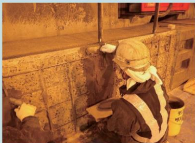
躯体補修工(左官)
