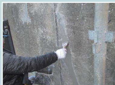
Vカット止水工
