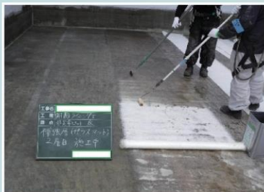
FRPライニング工
