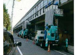
剥落防止(表面処理)
