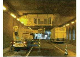
【内面断面補修】
