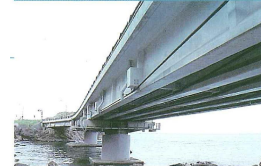
橋梁補強工(外ケーブル工法)
