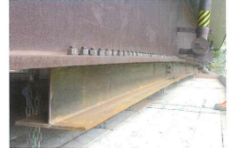
主桁補強工
