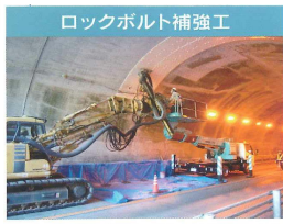
ロックボルト補強工
