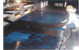
床版補強工(ストランドシート補強工)
