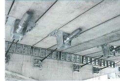
落橋防止構造(タイブリッジ・ツナイダル)
