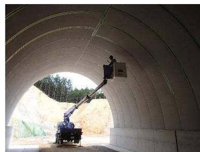
コンクリート構造物に発生しているひび割れ、剥離、剥落、析出物、錆汁、鉄筋露出、うき、豆板、漏水等の損傷を観察する外観調査を始め、電磁波レーダ法や電磁誘導法による鉄筋探査などコンクリート構造物の点検・調査の補助を行います。
