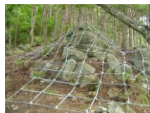
ケーブルネット ワイヤとクリップの締結で落石の発生を抑制
