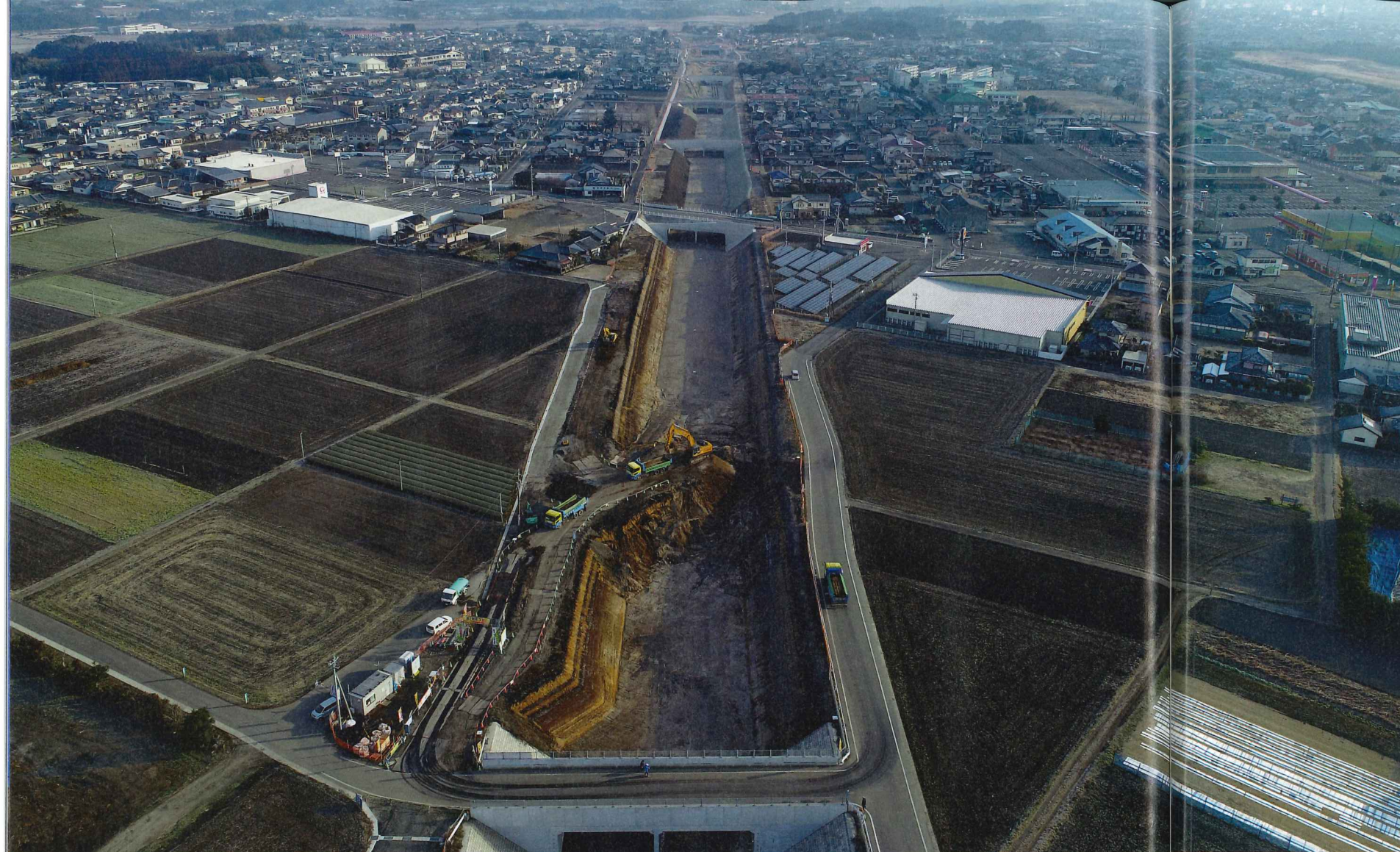
写真2 ■ ドローンで空撮した都城志布志道路の工事現場。写真上が都城IC方面。この区間は2018年度に暫定2車線で供用開始する計画で、旭建設は手前から延長470mの掘削の土工事と法面整形、植生工事などを手掛ける(写真:旭建設)
