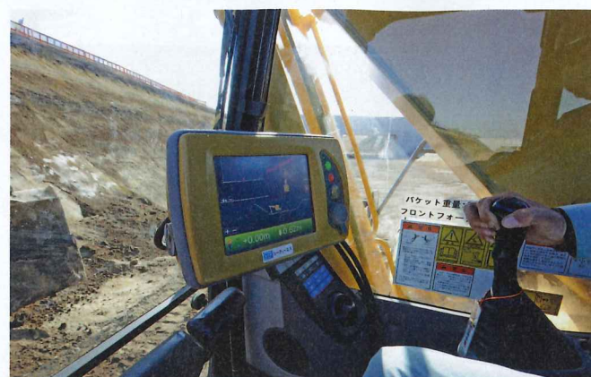
写真3 ■ 丁張りなしで法面を整形するバックホーの運転席。平バケットの刃先の位置と設計面との距離などをモニターに表示する
